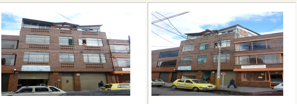
Registro Fotográfico predio ubicado en la KR 24 No. 68-25 – Localidad de Barrios Unidos – Evidencia construcción dos locales comerciales. Ingreso a la edificación por el centro del predio, según planos el acceso al segundo piso es en el costado lateral. Igualmente, se observa el cuarto piso construido en su totalidad.
