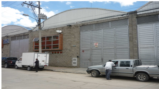
Fachada de la edificación, que no corresponde a uso comercial
