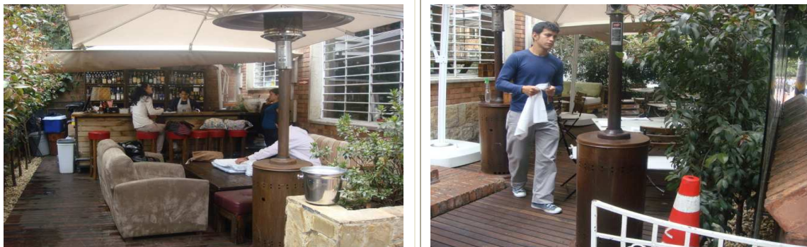
Registro Fotográfico Predio ubicado en la KR 10 A No. 70-62 – Localidad de Chapinero. Área de Antejardín sobre la Calle 70ª cubierta y aprovechada como zona de restaurante. Invasión del espacio público.
