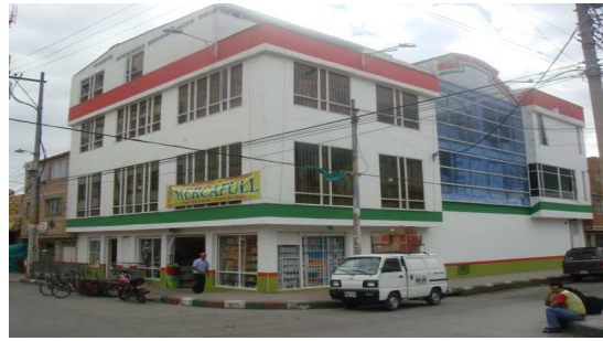
Registro Fotográfico Predio ubicado en la DG 50 S No. 27-058 – Localidad de Tunjuelito Se evidencia la supresión de los estacionamientos, cambio de uso y construcción de un piso más.
