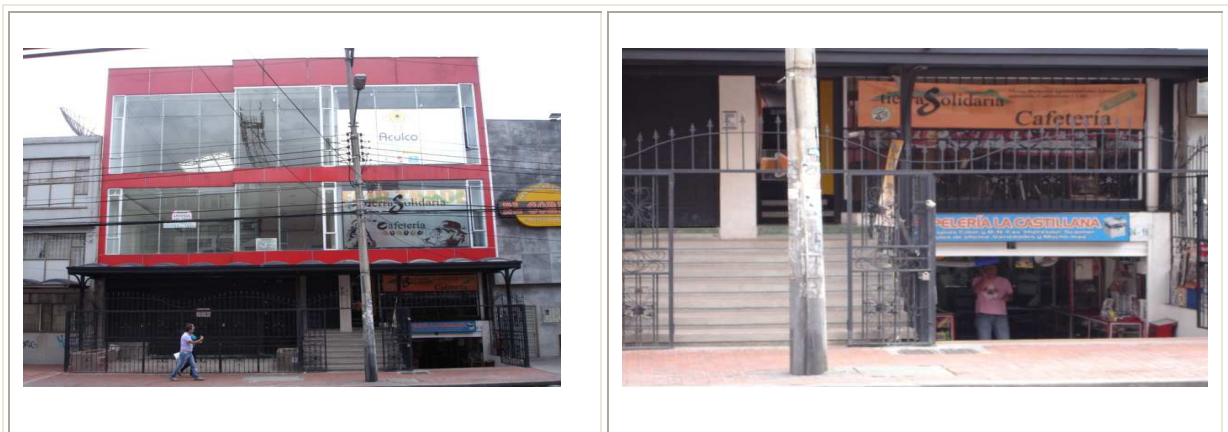
Registro Fotográfico: Predio ubicado en Calle 54 No. 24 – 18 Localidad Teusaquillo. Se evidencia la intervención e invasión del espacio público (antejardín); ausencia de rampa de acceso de vehículos a la edificación; semisótano construido; cambio en el nivel dos y tres e interrupción del empate de las edificaciones colindantes.
