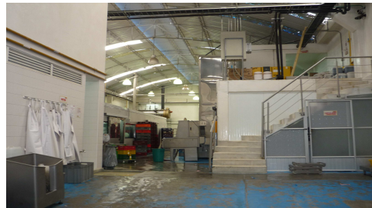
Construcción mezanine el interior del predio en la zona de comercio.
